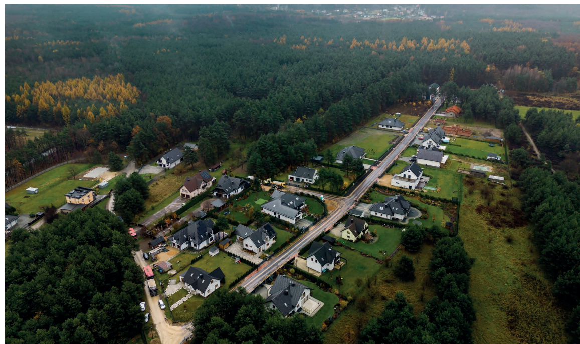
Budowa drogi ul. Borówkowej.
