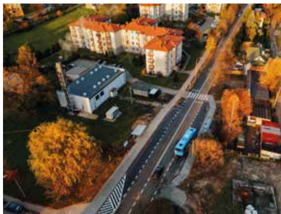
Wyremontowana ul. Szarych Szeregów.
