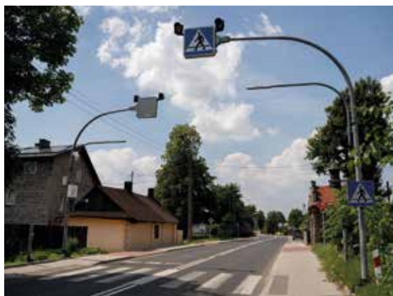
14 doświetlonych przejść dla pieszych (na zdjęciu: doświetlone przejście na ul. Śląskiej).
