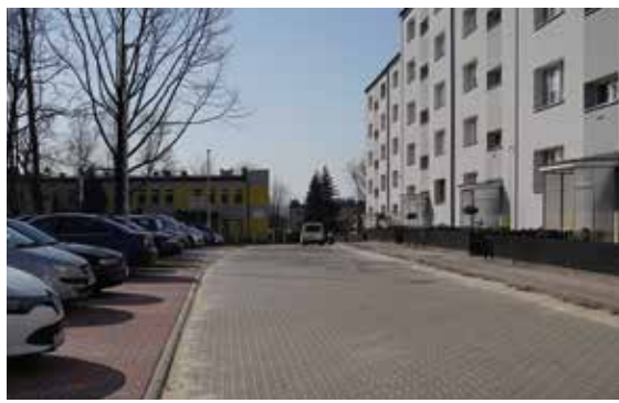
Przebudowa ul. Mieszka I.
