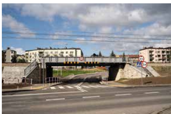
Zmodernizowany wiadukt na ul. 29 Listopada.
