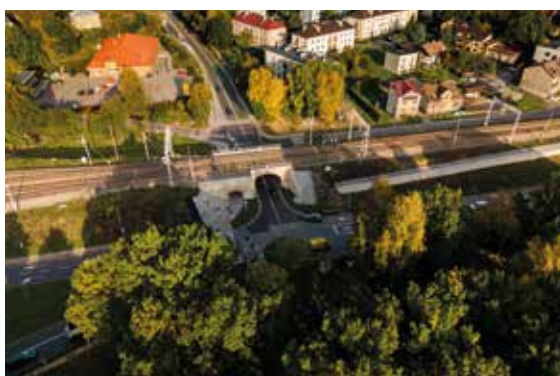
Zmodernizowany wiadukt na ul. Siennej.
