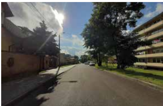
Budowa ul. Kościelnej.
