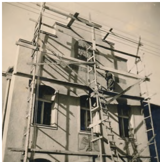
Przebudowa budynku Towarzystwa Gimnastycznego „Sokół” pod kierownictwem Karla Laabsa, I. 1941/1942, ze zbiorów Stefana Endresa.
