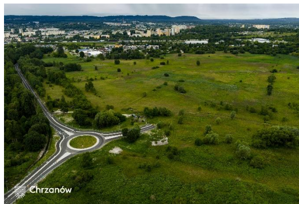
Budowa połączenia drogowego Chrzanowskiej Strefy Inwestycyjnej z węzłem autostrady A4 Chrzanów -Balin i drogą powiatową nr 1044K (ul. Wodzińska w Chrzanowie)
