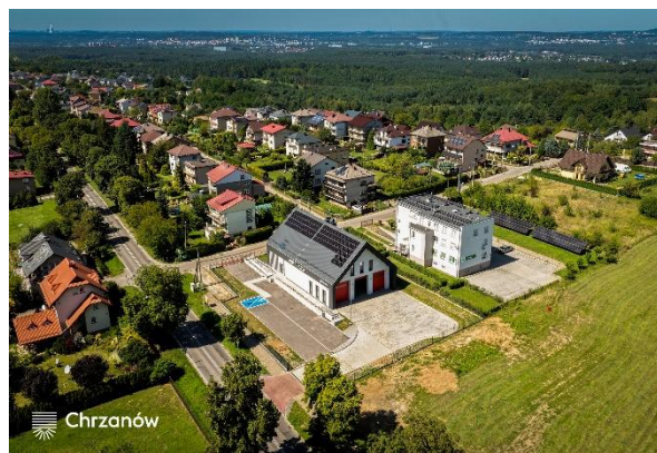
Budynek OSP w Płazie
